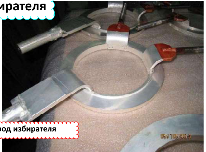
После механической обработки и наращивания меди
